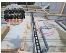
基礎に土台と360度床下換気可能な基礎パッキン施工
