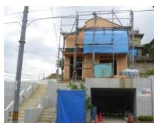
上棟(雨仕舞いの為基本1日で施工)後構造用壁面ボード施工
