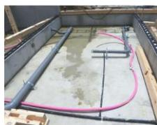
給排水管ベタ基礎上に施工引き込み管のみ基礎中施工
