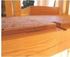
剛床造り、大引きの上に構造用合板施工、経年による床下がり少なく横揺れに対して面で突っ張る作用がある。
