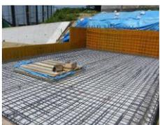
**ベタ基礎鉄筋施工**
